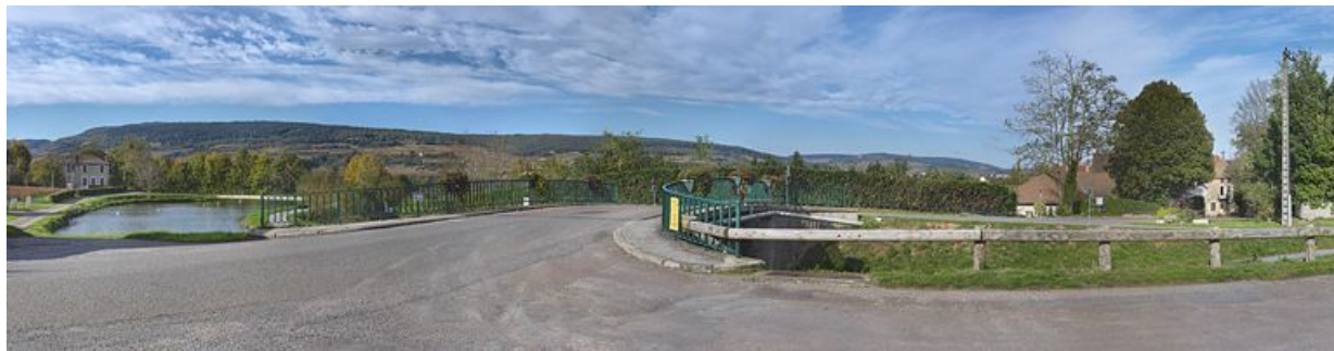
Vue du pont routier et du paysage du canal à Cheilly-lès-Maranges : les vignes et le moulin Sorine de Santenay.
