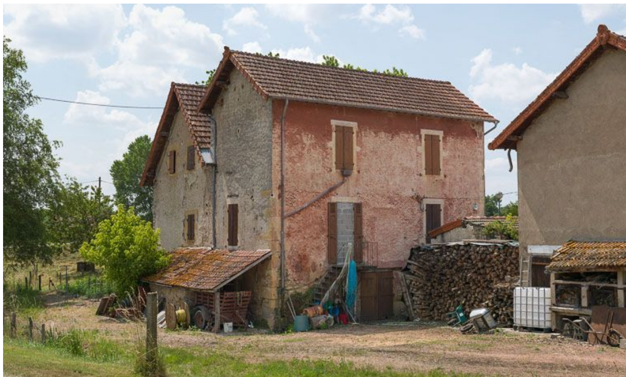
Façades postérieures de la maison éclusière et de la maison pour un garde.
