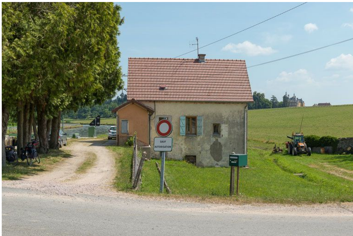
Façade latérale de la maison éclusière. On devine le château de Digoine en arrière-plan.
