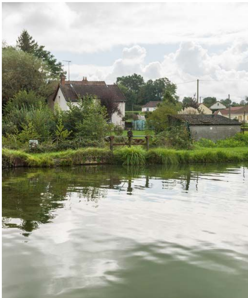
Vue de la prise d'eau, avec le canal au premier plan.
