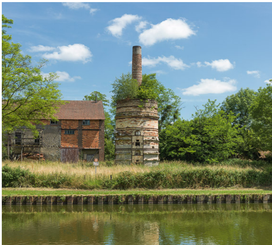
Vue de la cheminée de l'ancienne usine, rive gauche.
