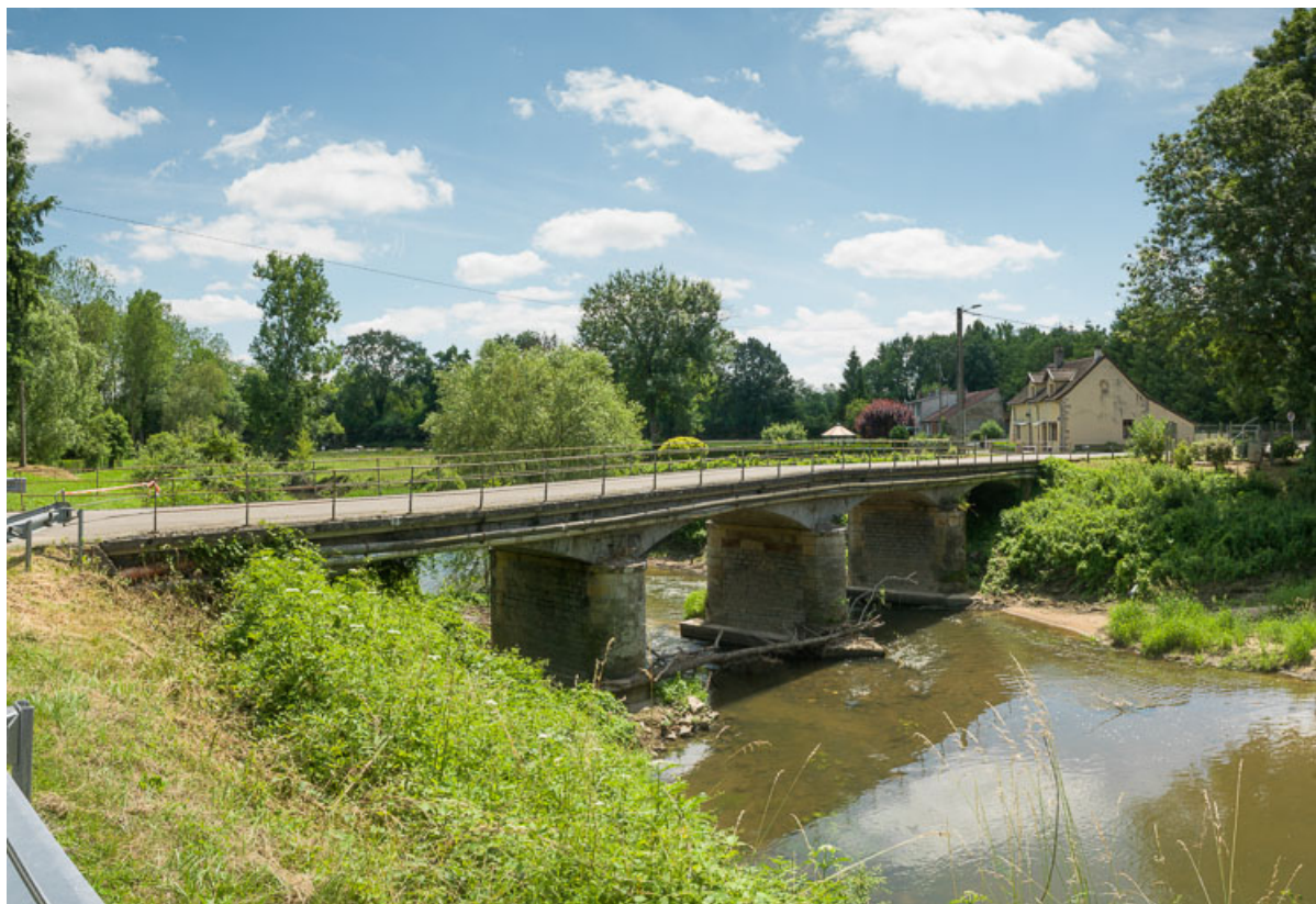
Vue du pont sur la Bourbince, en aval du château.
