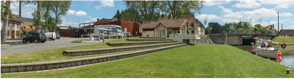
De gauche à droite : le Centre d'interprétation de la ligne de démarcation, le pont sur écluse (IA71002434) et un quai du port. 71, Gévelard, lieudit : bief 17 du versant Loire-Océan
