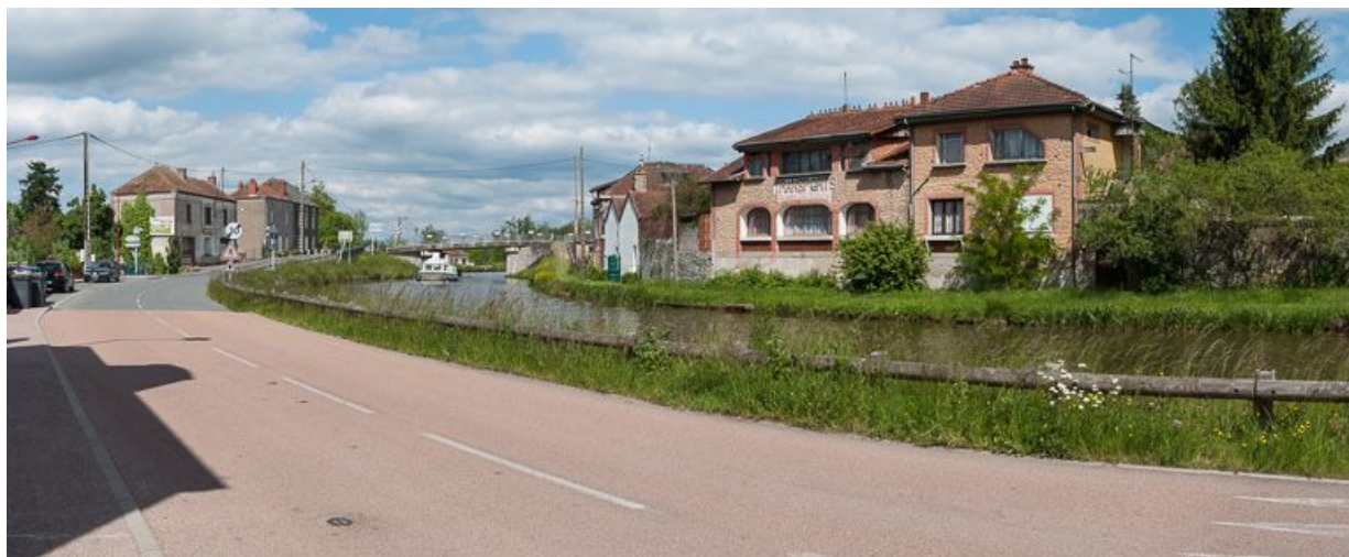
Vue d'ensemble du village depuis le canal avec au premier plan, les bâtiments de l'ancienne société de transports Martin. 71, Ciry-le-Noble, lieudit : bief 14 du versant Loire-Océan
