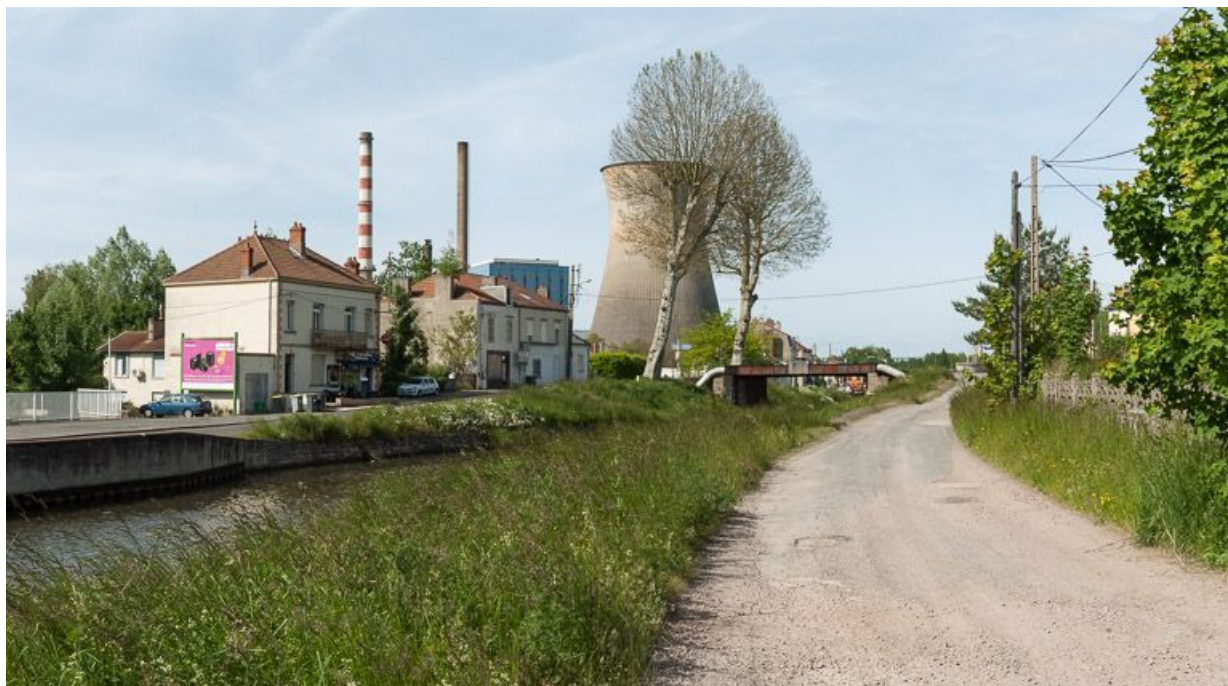
Vue d'ensemble du pont, avec la centrale de Lucy en arrière-plan.
