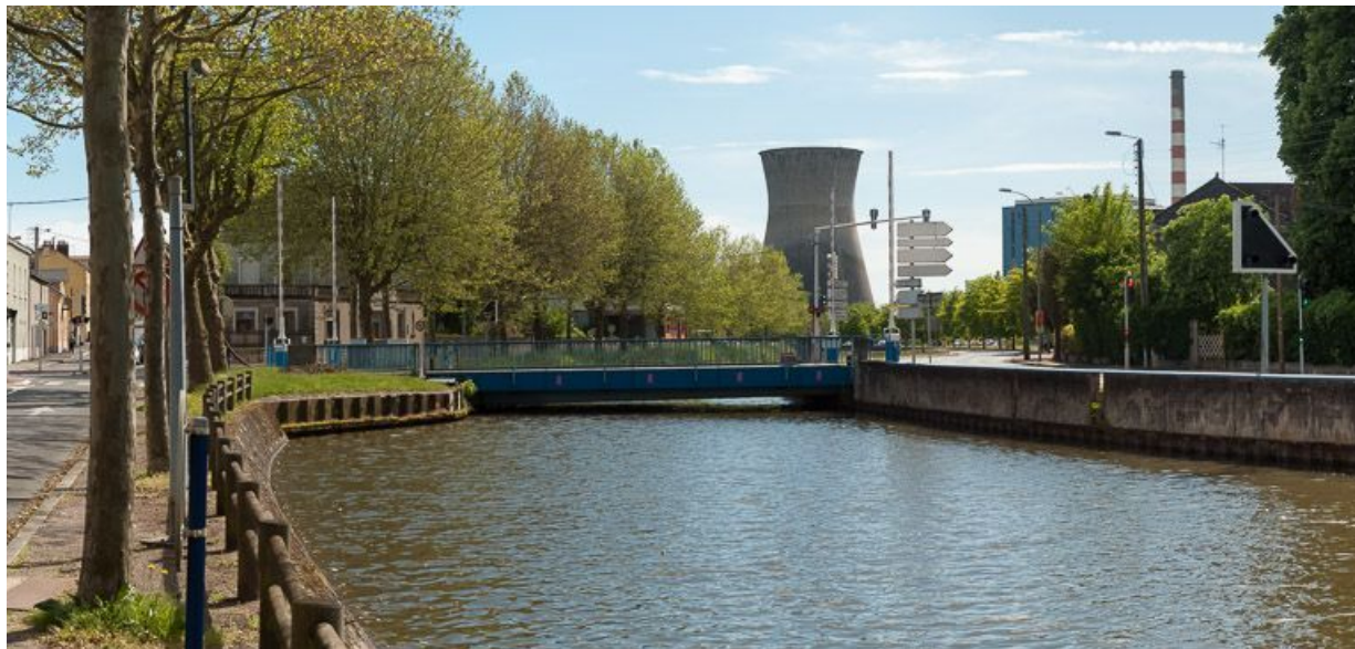
Vue d'ensemble du pont.
