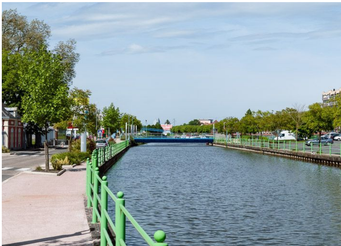
Vue d'ensemble avec le port de Montceau-les-Mines en arrière-plan.
