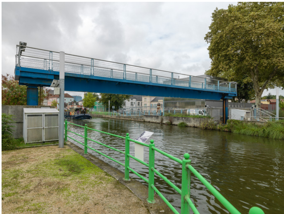
Passerelle remontée après le passage d'un bateau.
