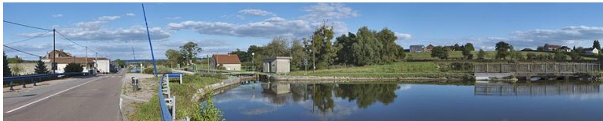
La maison éclusière 02 en contrebas du bief 02. Le réservoir de dépôt lié à la rigole alimentaire et régulatrice de l'échelle d'écluses. 71, Écuisses, lieudit : bief de partage
