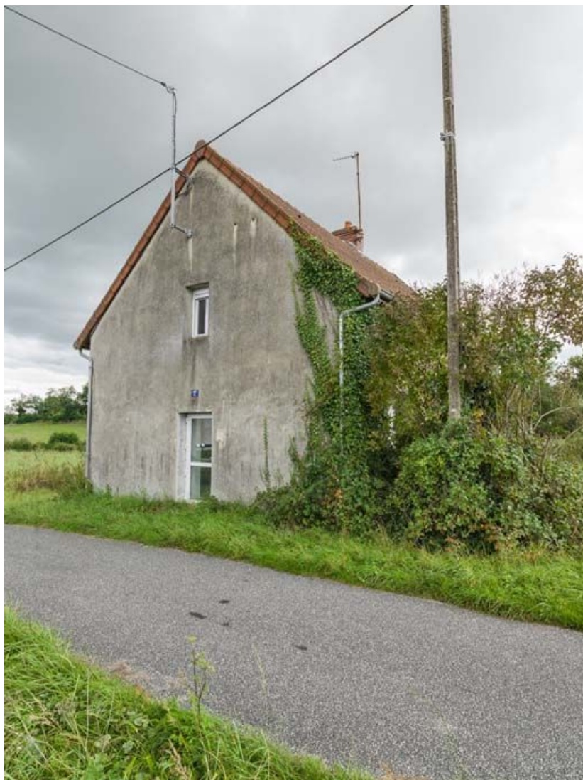
Vue rapprochée de la maison éclusière et de son mur pignon.
