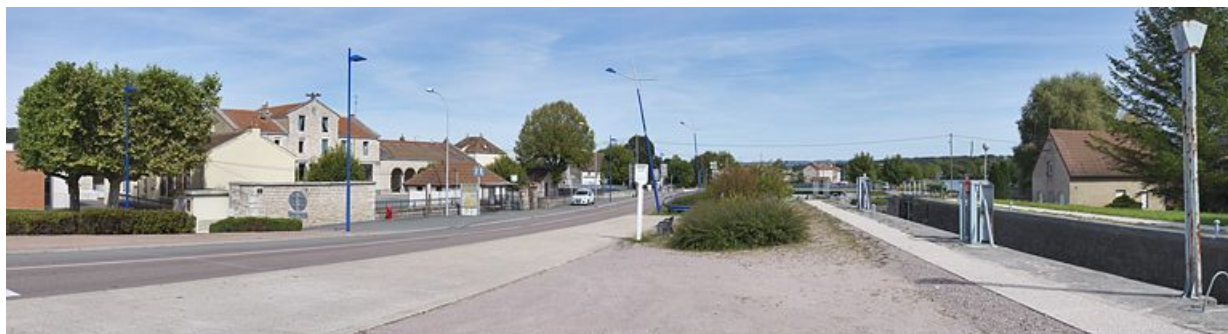
Vue d'ensemble prise d'amont de la mairie. Au fond, le monument aux morts. A droite, site d'écluse 04 avec maison. 71, Écuisses, lieudit : bief 05 du versant Saône-Méditerranée
