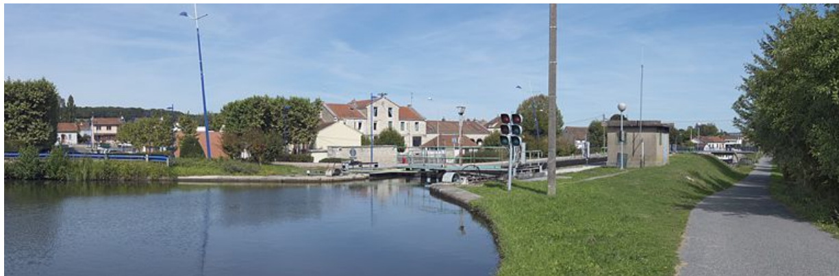
Vue d'ensemble prise d'amont du bord du canal à Écuisses avec la mairie et le site d'écluse 04.
