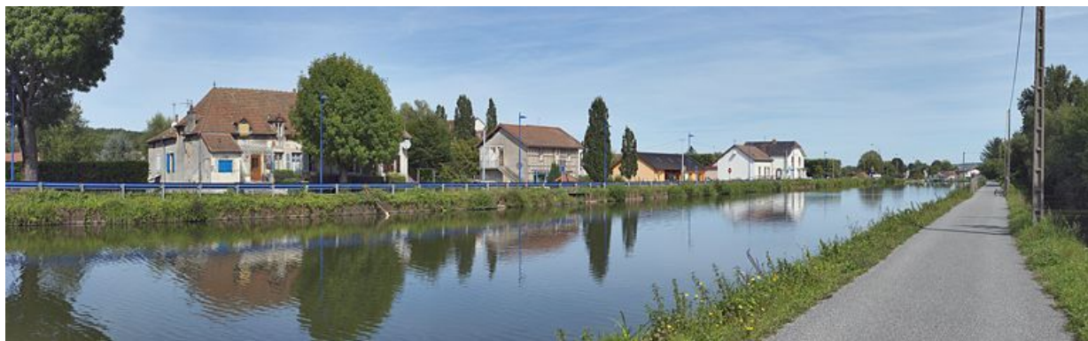
Vue d'amont des petits commerces installés le long du canal du Centre.
