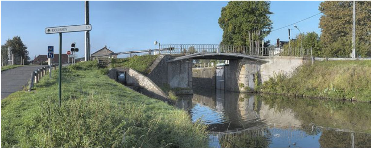
Le site d'écluse 05 vu du bief 06. Pont sur écluse avec escalier. Arrivée de la rigole régulatrice des biefs. 71, Écuisses, lieudit : bief 05 du versant Saône-Méditerranée
