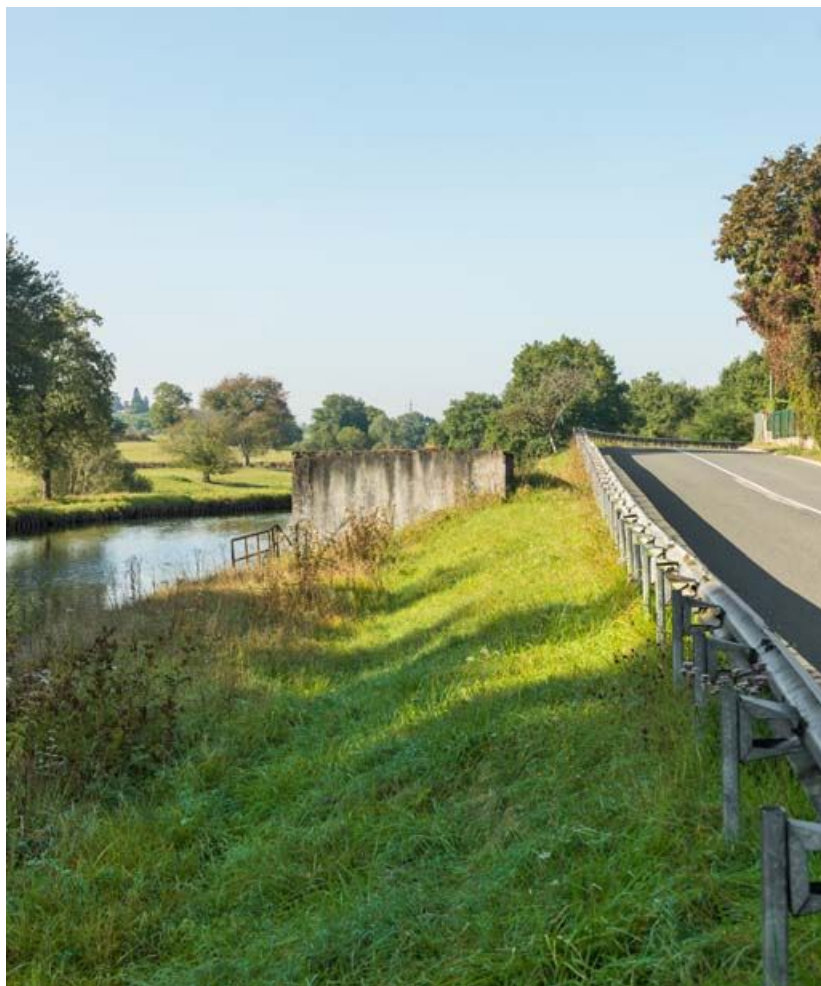
Vue du bâtiment rectangulaire à toit plat, vestige de la tuilerie.
