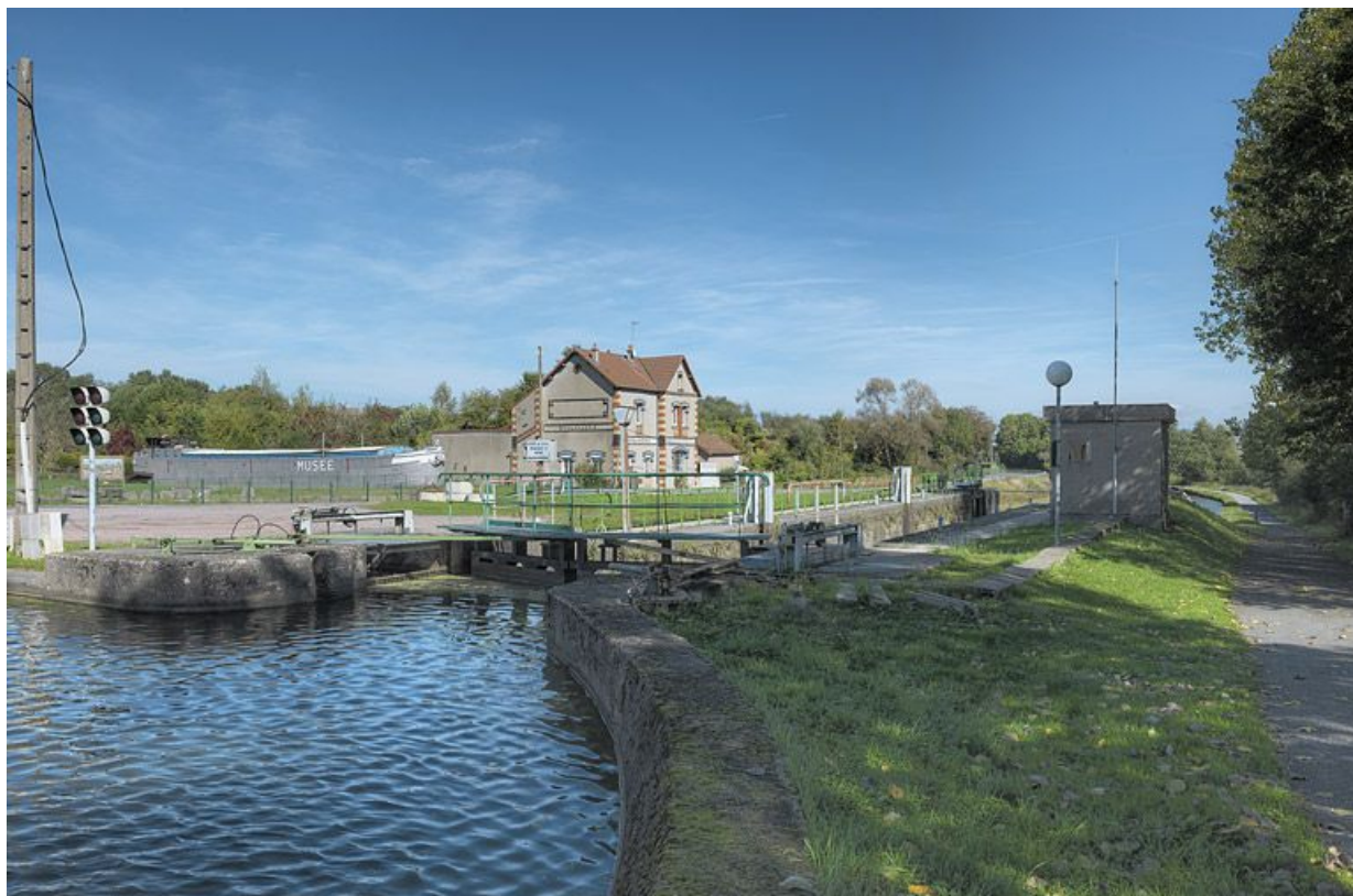
Le site d'écluse 06 vu d'amont et péniche servant de salle d'exposition au Musée du Canal. La boulangerie de la cité Perrusson dans le prolongement.
