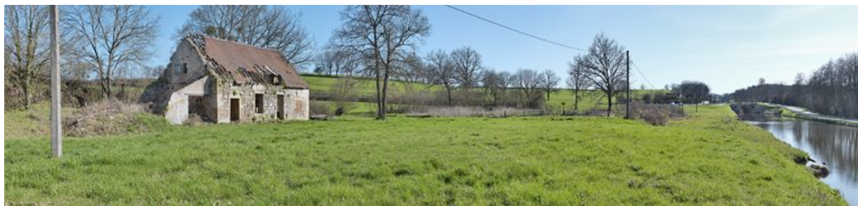
La maison éclusière avec à droite, le canal du Centre et en arrière-plan le site d'écluse 10.
