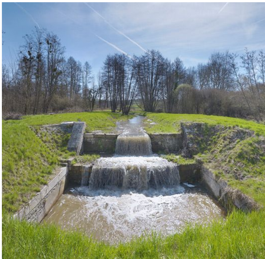
Palier et bassin de décantation avant le passage sous le canal.
