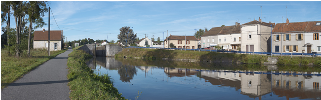
A Ecuisses, le bief 03 pris de l'aval de la rive droite. Alignements de maisons le long du chemin de halage devenu route départementale.
