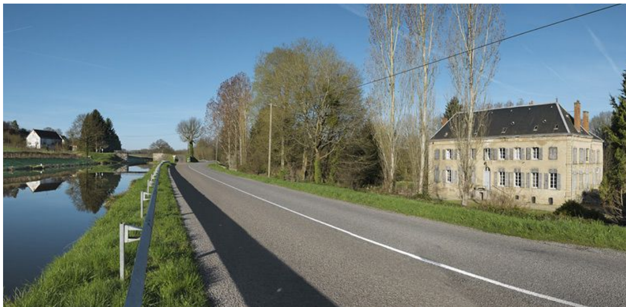
Vue d'ensemble du château, depuis la rive gauche du canal.
