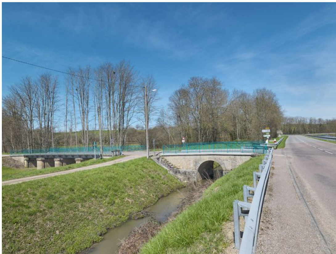
Le pont sur contre-fossé. A sa gauche, le pont sur la Dheune. A droite, le canal.
