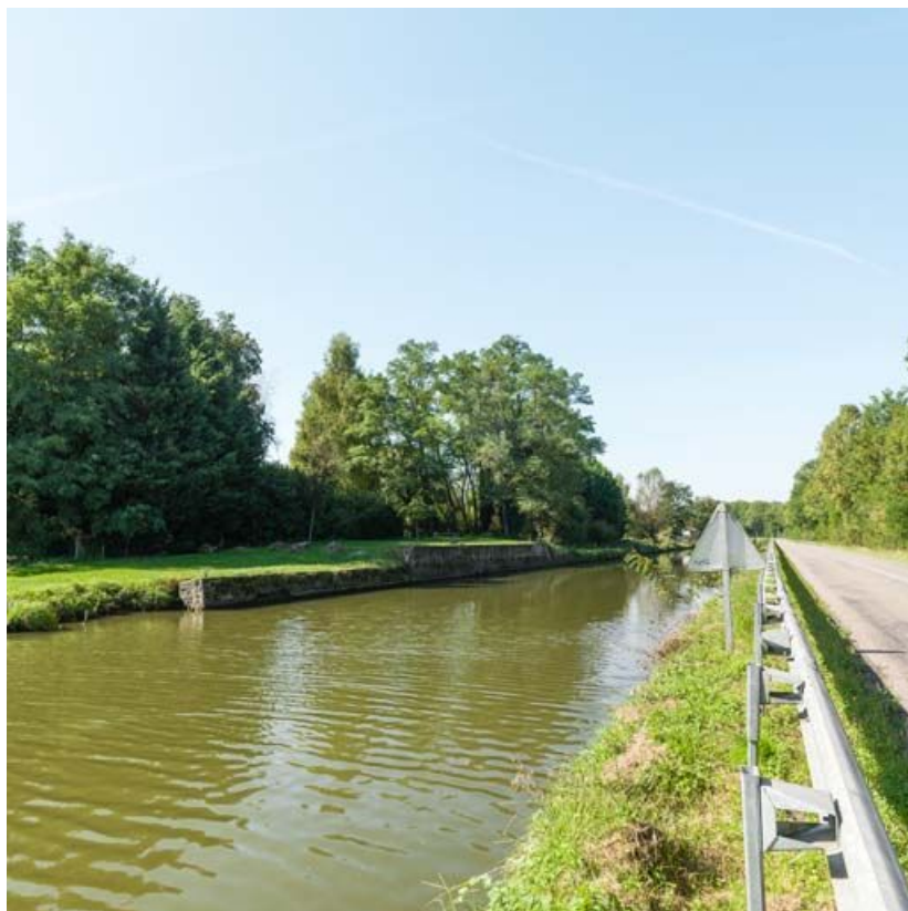
Vue du quai en moellon de calcaire qui permettait de charger les bateaux.
