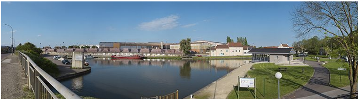
Vue d'ensemble du port avec l'usine Terréal et à droite, l'oeuvre d'art contemporaine, prise depuis le pont (IA71002226). 71, Chagny rue Léon Saccard, lieudit : bief 24 du versant Saône-Méditerranée
