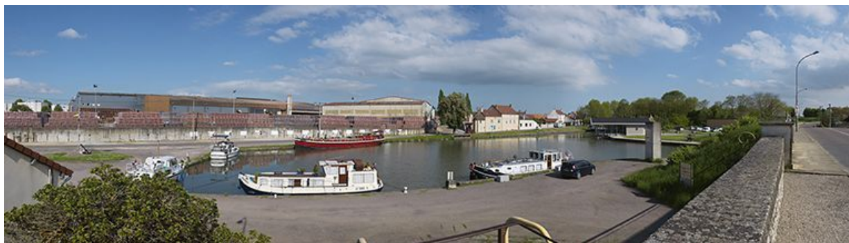
Vue d'ensemble du port avec l'usine Terréal et à droite, l'oeuvre d'art contemporaine, prise depuis le pont (IA71002226). 71, Chagny rue Léon Saccard, lieudit : bief 24 du versant Saône-Méditerranée
