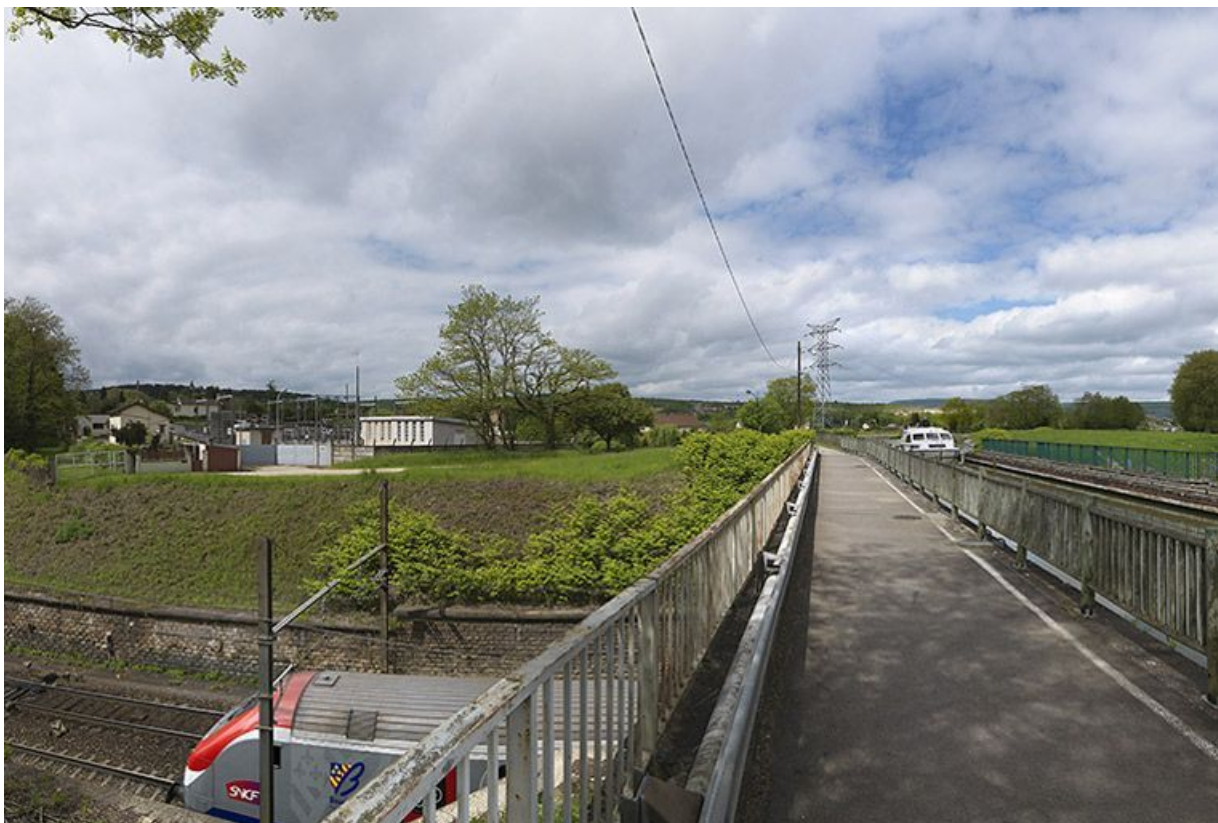
Vue d'ensemble du pont-canal avec la voie ferrée en dessous.
