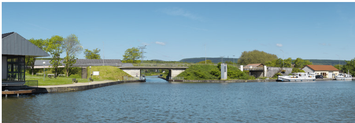
Vue d'ensemble du pont en arrière plan du port de Chagny.
