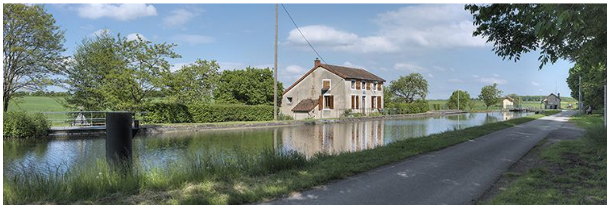
Vue d'ensemble du site avec au centre la maison éclusière et à gauche le déversoir.
