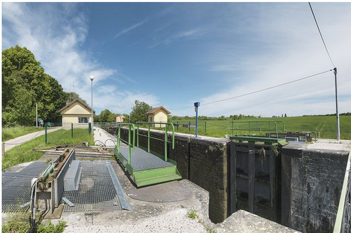
Le site d'écluse avec les deux postes de commande, pris d'aval. Dans le fond, on distingue la maison éclusière. 71, Chagny, lieudit : bief 24 du versant Saône-Méditerranée
