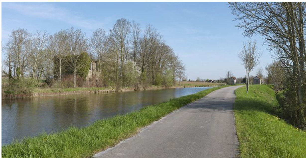
Vue d'ensemble avec à gauche l'ancienne maison du site d'écluse XXXIII, en amont du site d'écluse 25.
