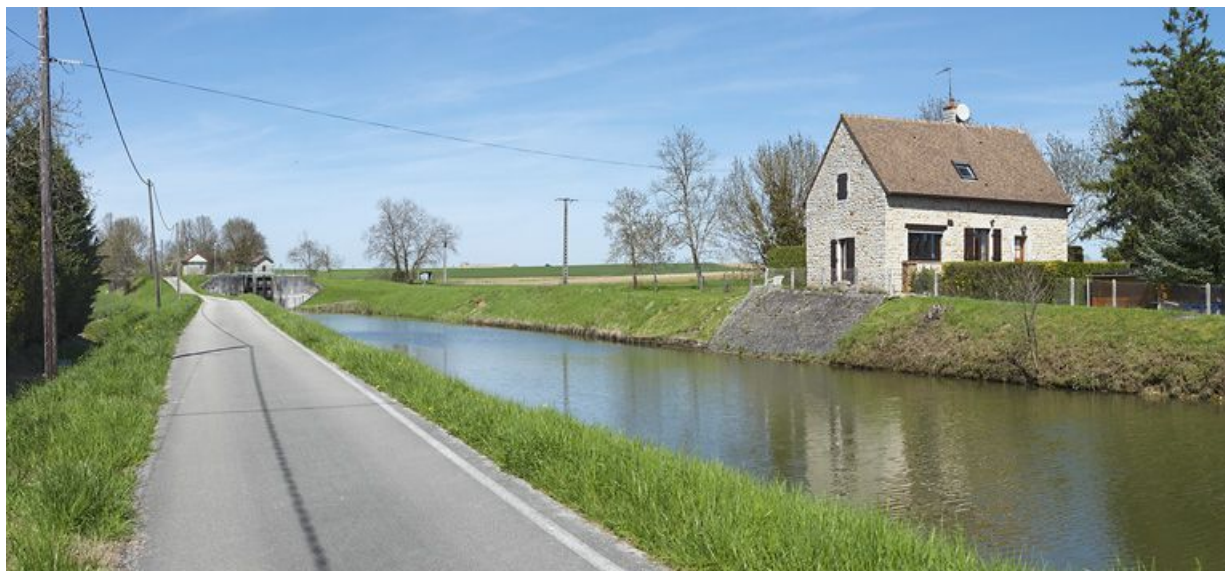
Vue d'ensemble avec à droite, la maison du site d'écluse XXXIV, en aval du site d'écluse 25 que l'on voit en arrière-plan. 71, Rully, lieudit : bief 26 du versant Saône-Méditerranée
