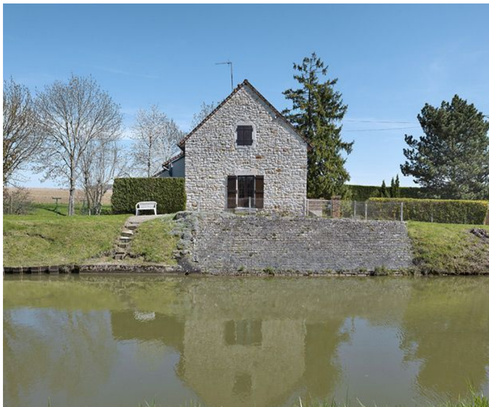
Vue de face de la maison du site d'écluse XXXIV avec le perré.
