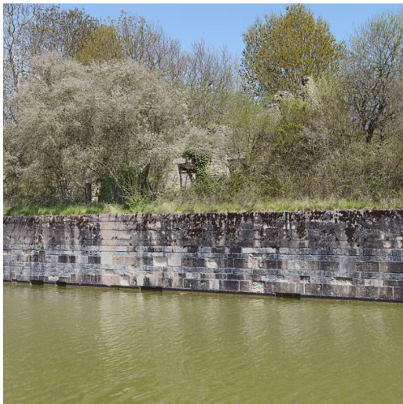
Vue rapprochée sur le bajoyer. On aperçoit la maison éclusière derrière la végétation. 71, Rully, lieudit : bief 29 du versant Saône-Méditerranée
