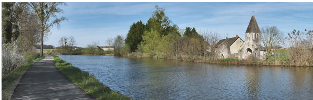
Vue d'ensemble du canal avec sur la rive gauche l'église de La Loyère.
