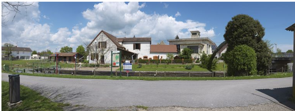
Vue d'ensemble du site : au centre la maison éclusière et à droite, la station de pompage.
