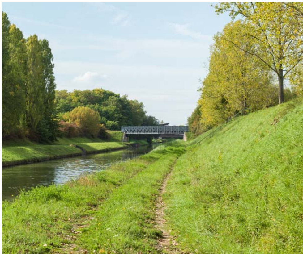
Vue du chemin de halage et du pont, en arrière plan.
