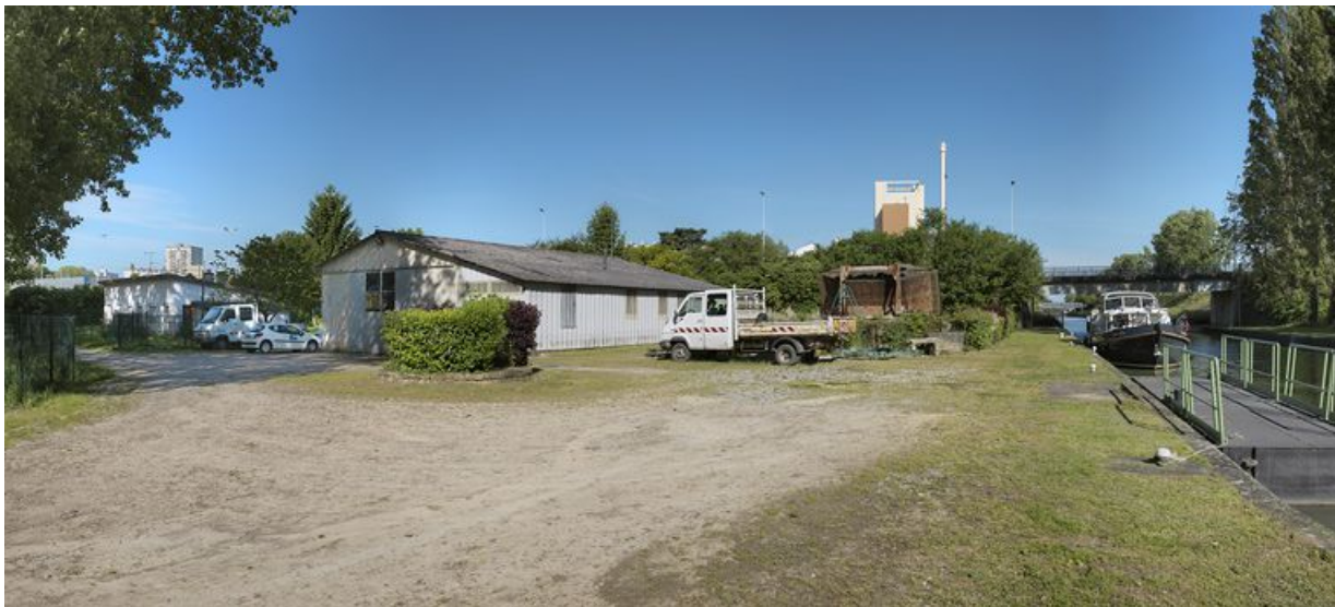
Rive droite, vue de l'atelier et de la maison éclusière.
