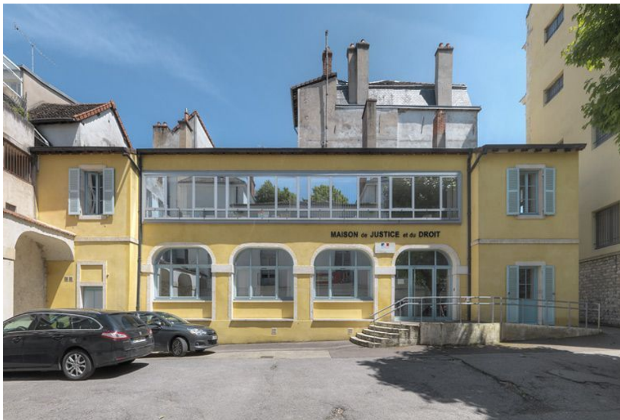
Anciens locaux des archives du canal, avec leurs baies en anse de panier.
