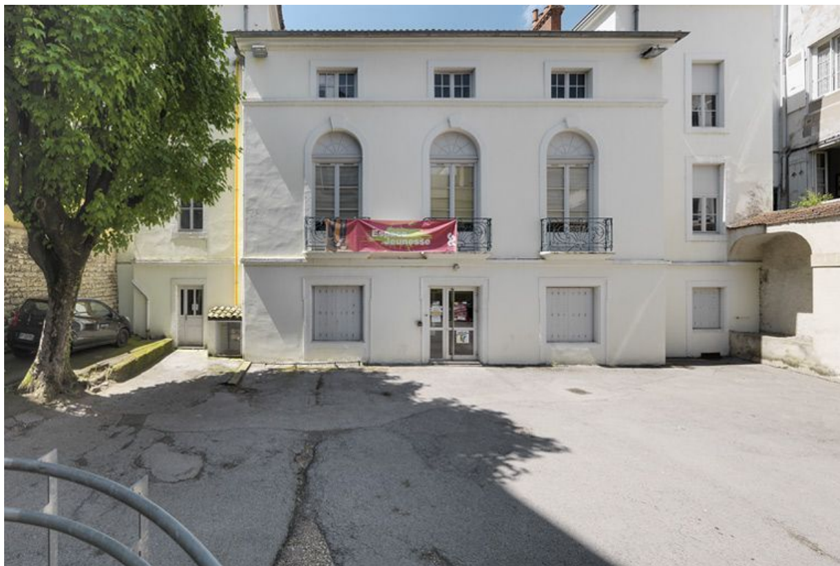
Façade sur cour de la maison des Arquebusiers.
