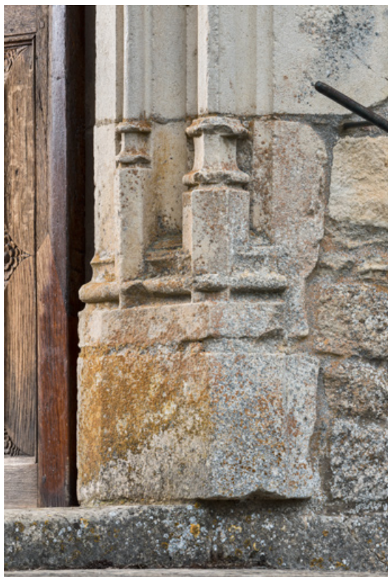
Piédroit, détail de la partie inférieure, droite.
