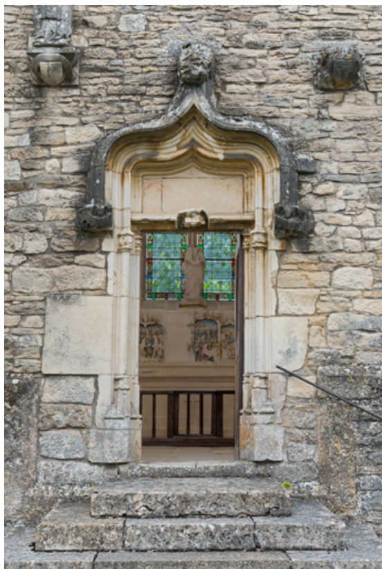
Porte en façade occidentale (vantail ouvert).
