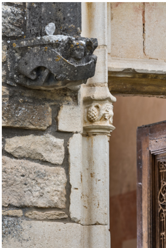
Piédroit, détail de la partie supérieure, gauche.
