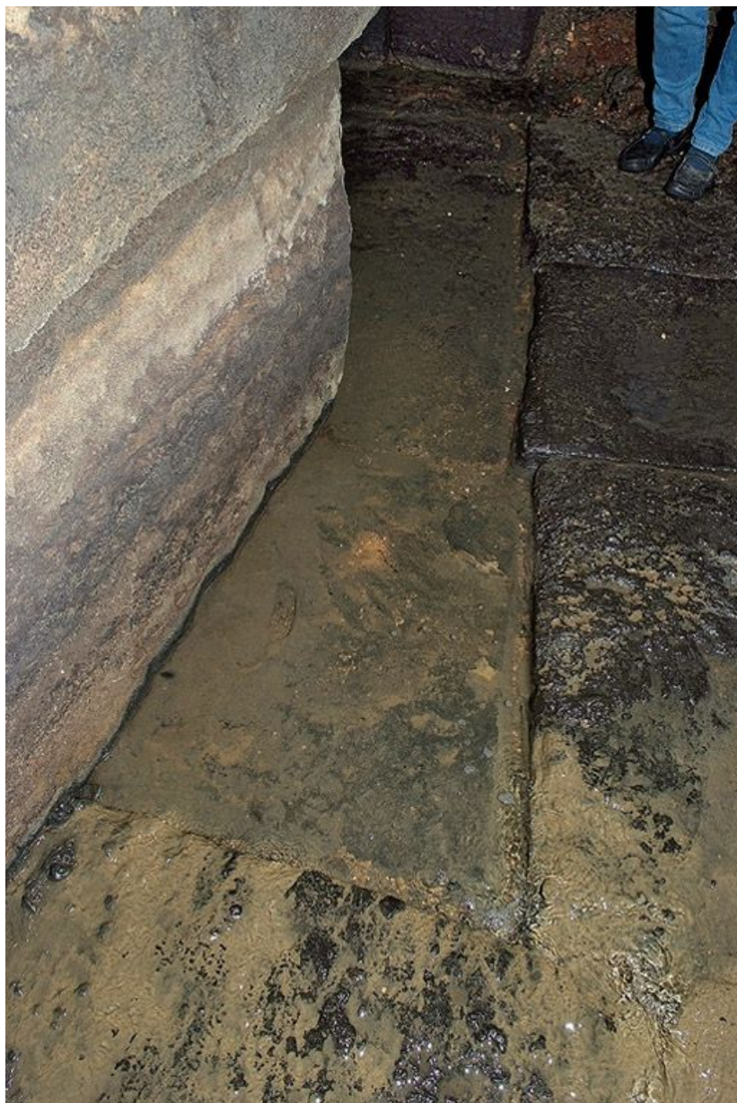
Angle de la section intermédiaire avec la deuxième galerie. 71, Bourbon-Lancy Parc Thermal
