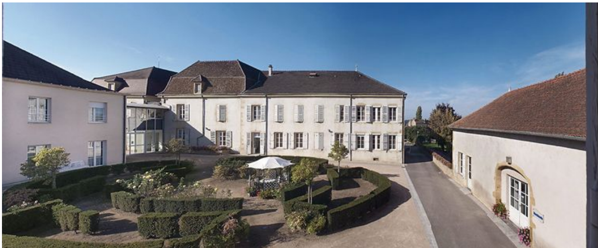
Bâtiment donnant rue de la Gare, façade postérieure du corps gauche.
