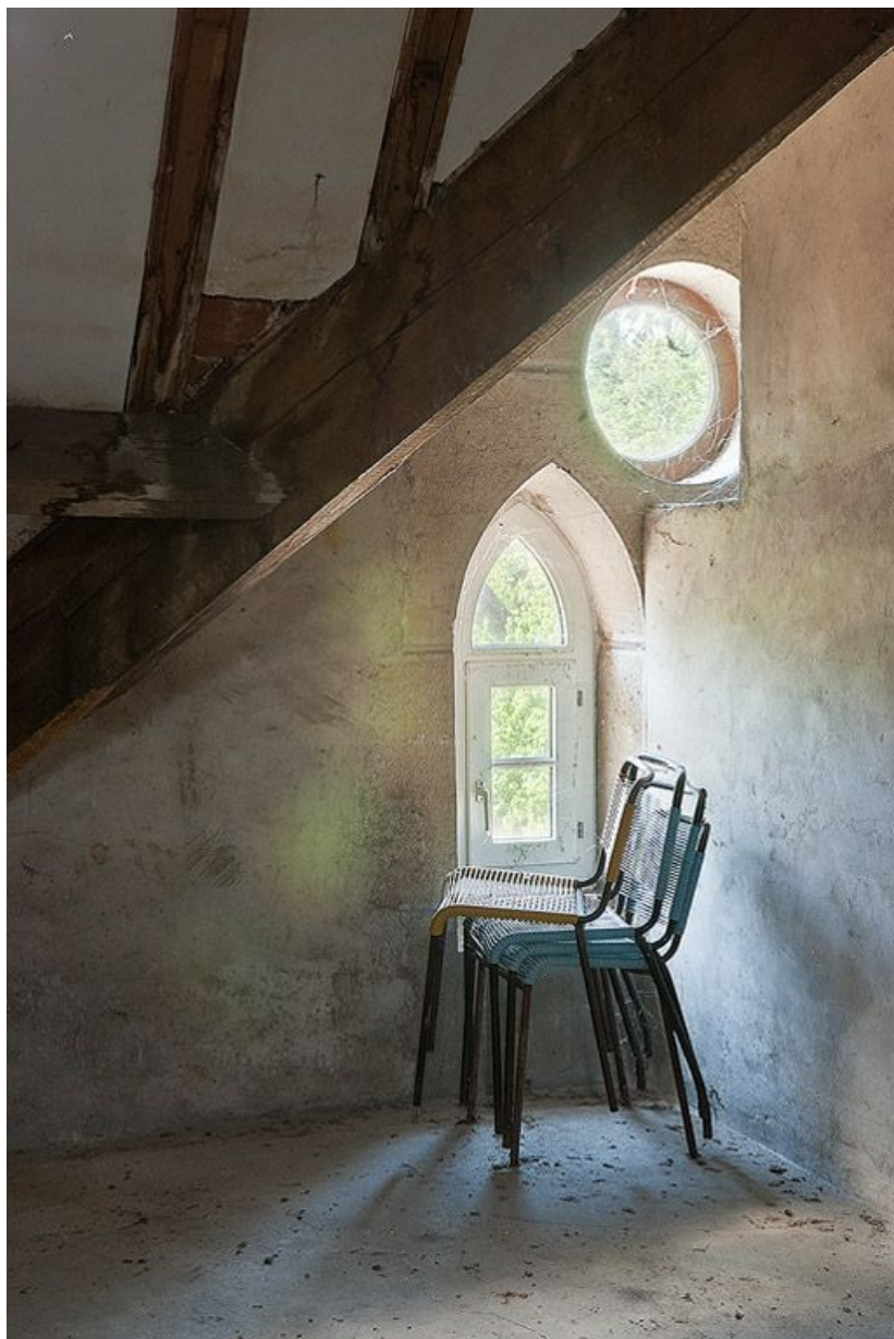
Comble : vue vers le pignon de la façade.
