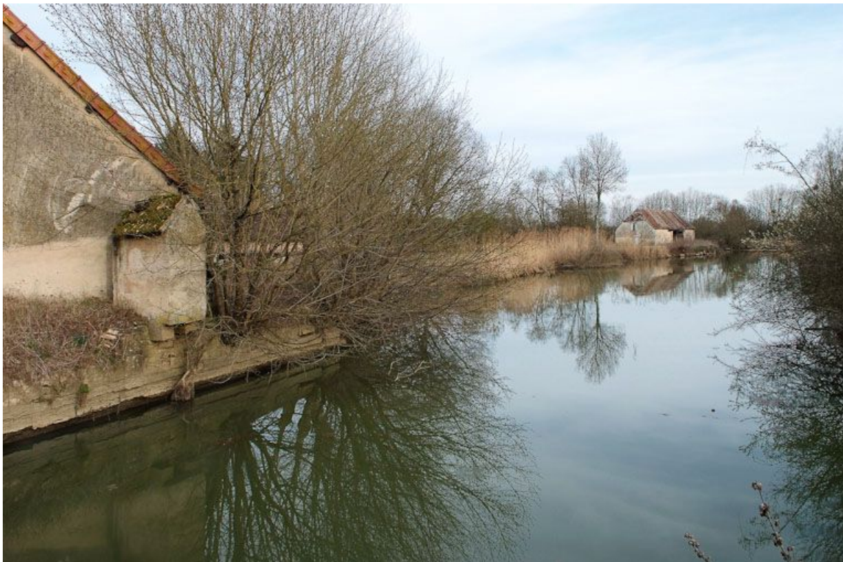
A gauche, latrines d'un bâtiment annexe au moulin principal. Au fond, le moulin à foulon. 71, Branges R. D. 167
