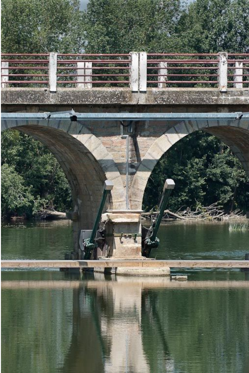
Vue rapprochée du barrage et du pont de La Truchère : une pile du pont. On voit deux des vérins hydrauliques qui commandent la levée du barrage.
