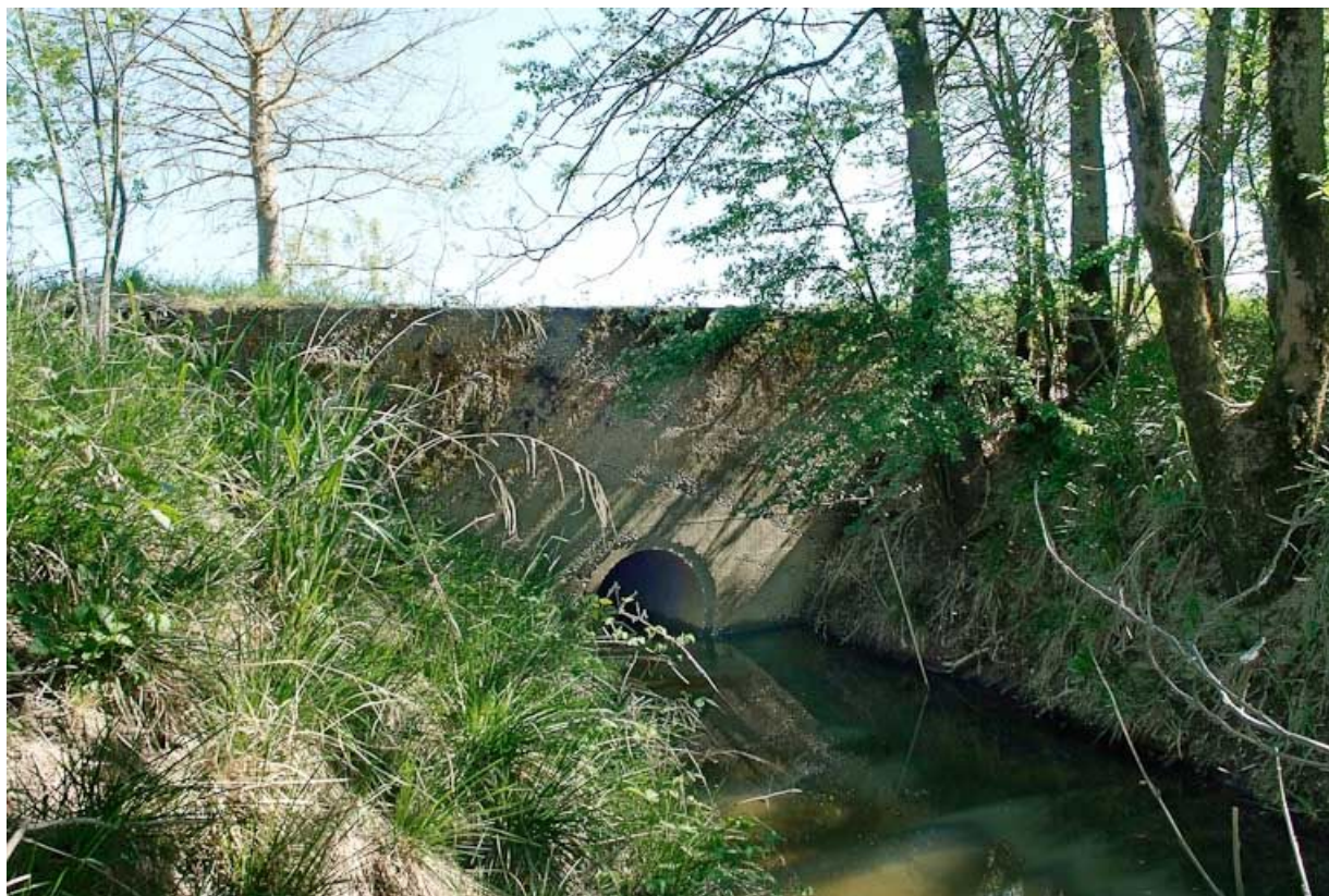
Pont ancien modifié par le passage d'une buse en béton.
