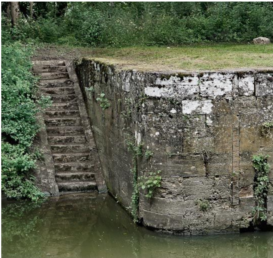
Détail de l'escalier en tête aval de l'écluse, rive gauche.
