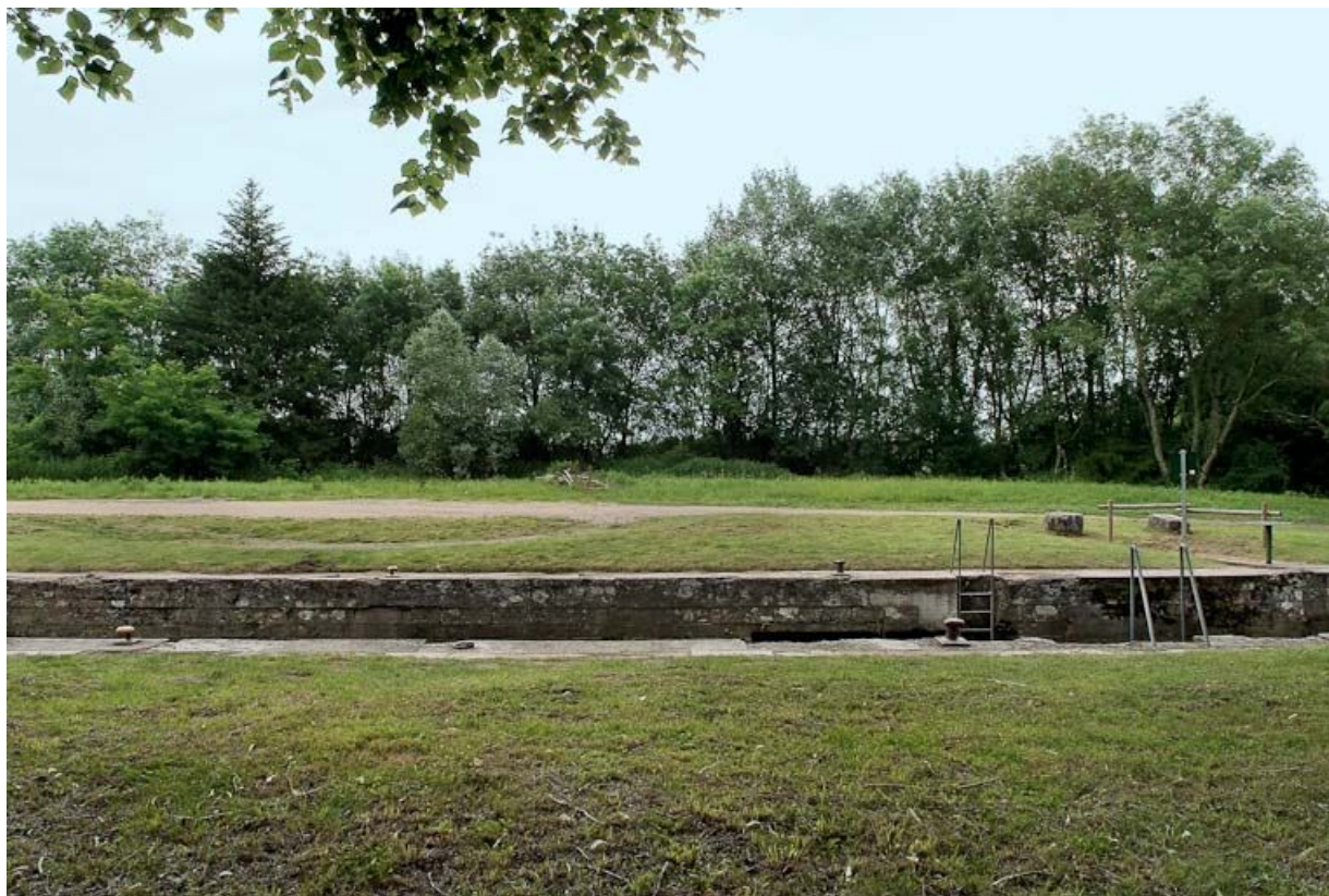
Le sas de l'écluse, avec l'emplacement de la maison éclusière à l'arrière-plan.
