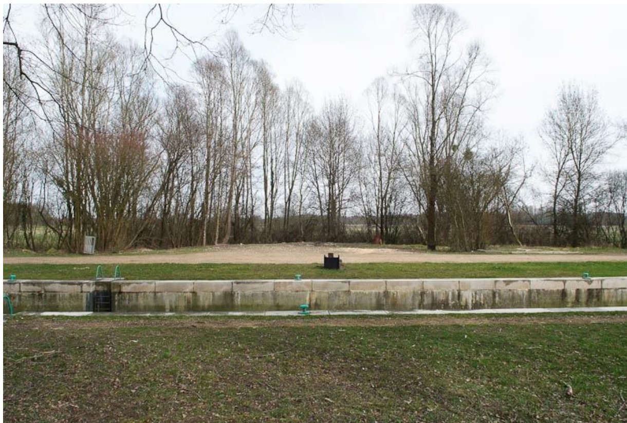
Emplacement de la maison éclusière détruite. Sas au premier plan.
