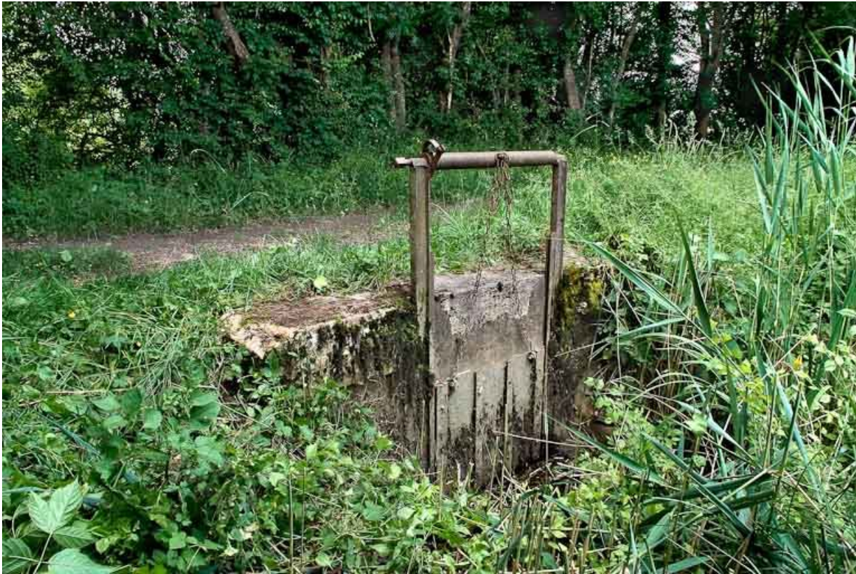
Vue rapprochée de la vanne de l'aqueduc.
