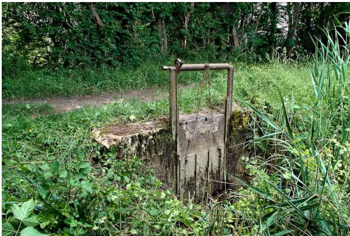
Vue rapprochée de la vanne de l'aqueduc.
