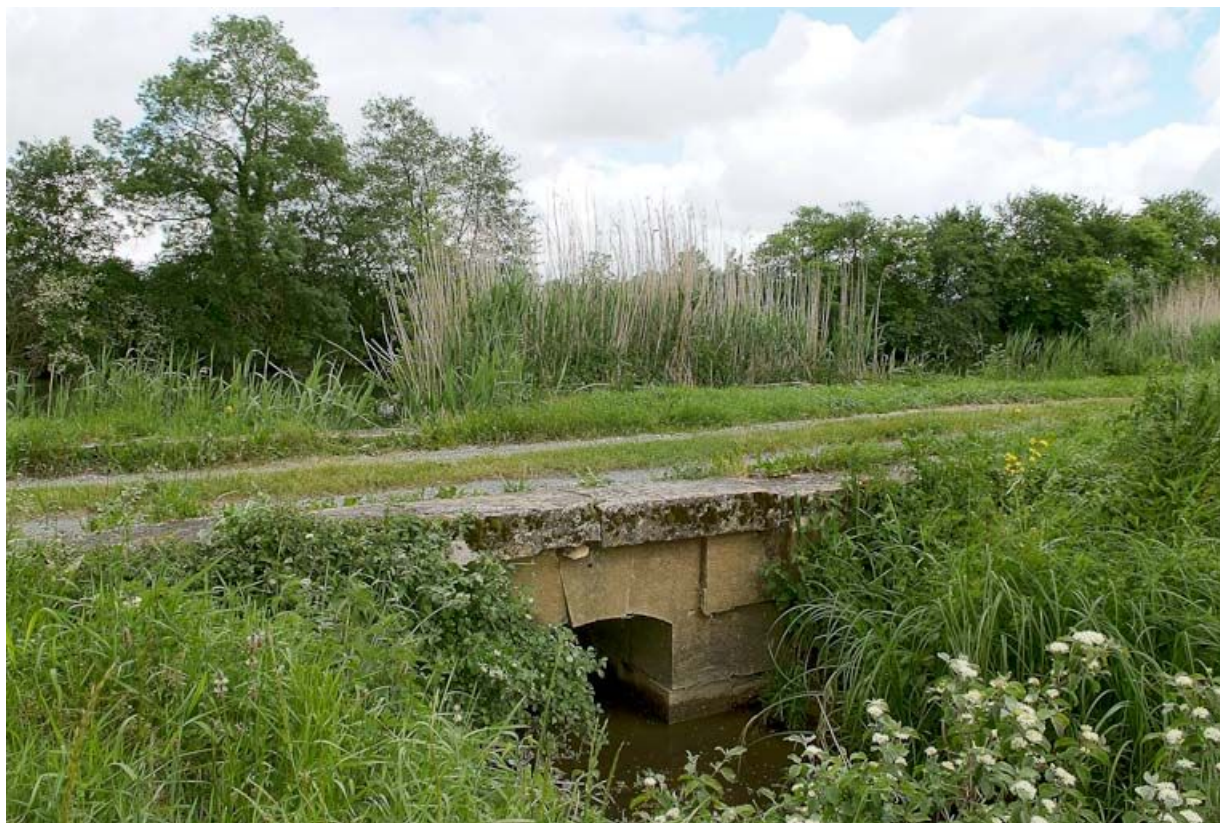
Ponceau en pierre sur un affluent de la Seille, Seille en arrière-plan de l'image.
