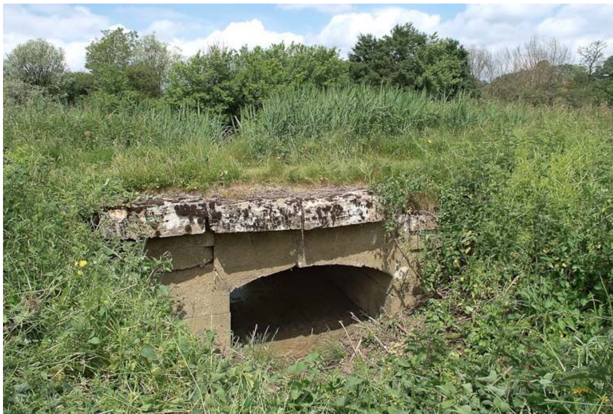
Pont en pierre sur un affluent de la Seille. Seille en arrière-plan.
