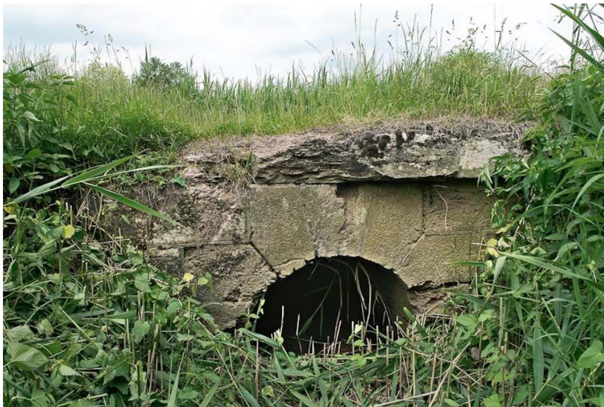
Ponceau situé à l'endroit de l'ancien passage du bac.
