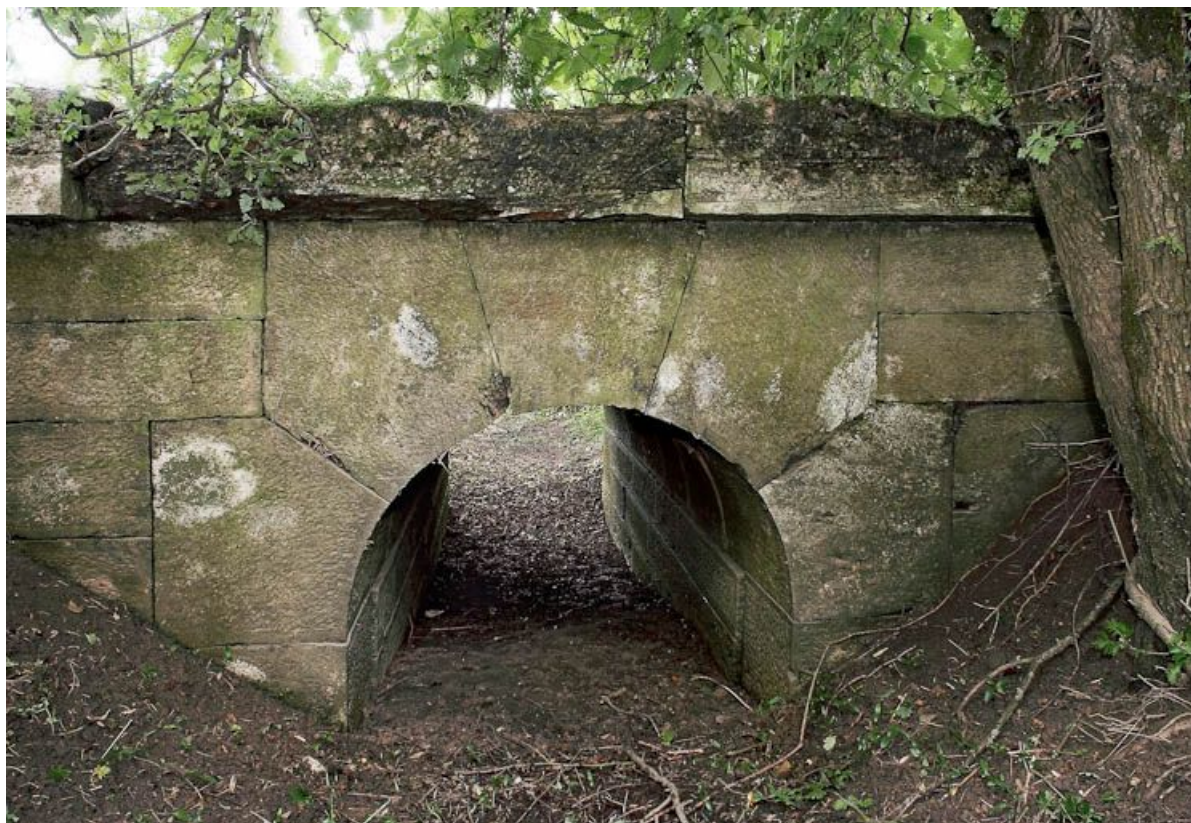
Ponceau, vue rapprochée.
